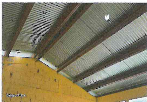
Foto 3: Techo deteriorado
